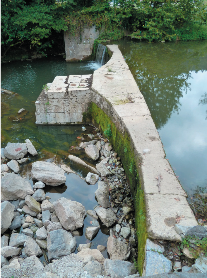
Fig. 15 Presa de Oxillain. Proyecto de P.B. Villareal de Berriz. Anterior 1736. (Markina, Bizkaia) Dos arcos de 12 m. Altura 2,50 m. Foto del autor.
