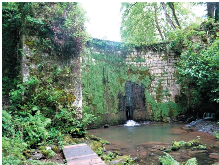
Fig.s 30/31 Presa del molino y ferrería de Lili. (Zestoa, Gipuzkoa) Arco: 9,70m. Alto. 8,40 m. Foto y dibujo del autor.
