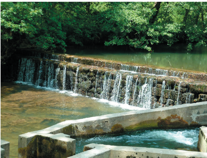
Fig. 7 Presa de piedra de Ezeza. Longitud:32 metros. Salto:2,60 metros. Estribos en las dos orillas. Foto del autor.
