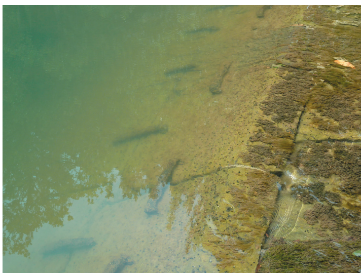
Fig. 33 Coronación de la presa de Lariz (Gizaburuaga. Bizkaia) Foto del autor. .
