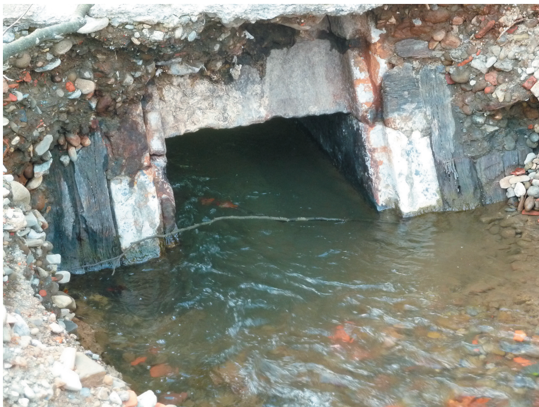
Fig. 34 Boca de aguas arriba del desagüe de fondo de la presa Oxillain. Foto del autor.
