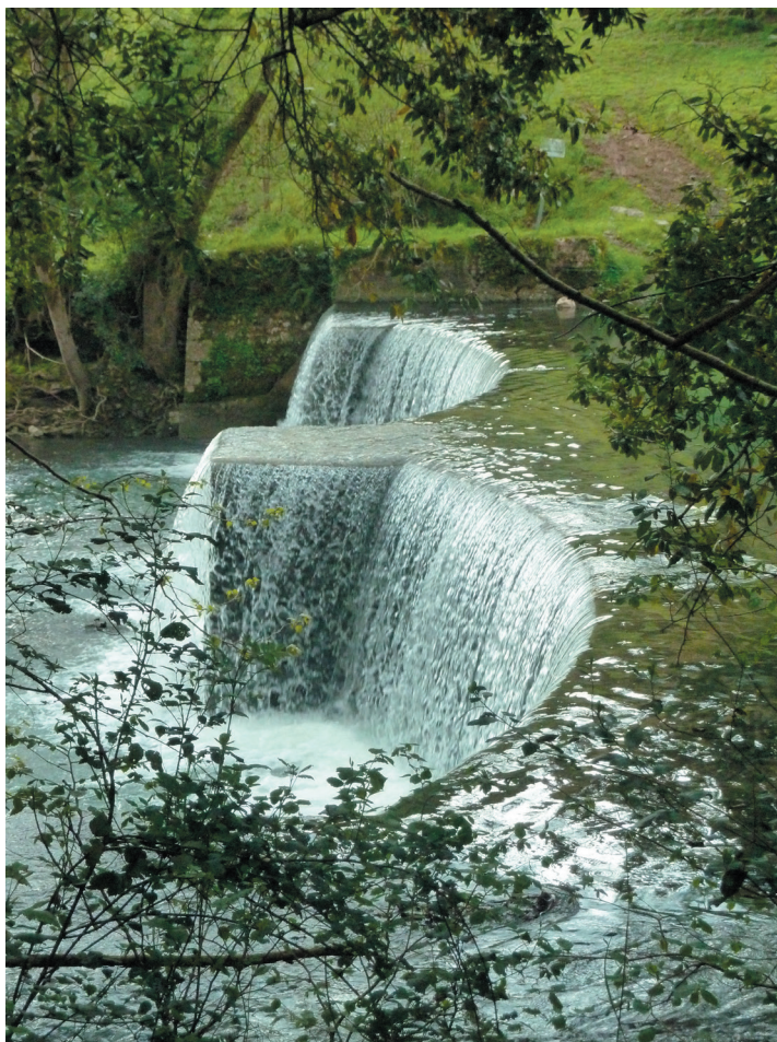
Fig.s 21/22 Lariz Oleta. (Gizaburuaga. Bizkaia) Dos arcos de 12,90 m. Alto: 3,10m. Foto y dibujo del autor.
