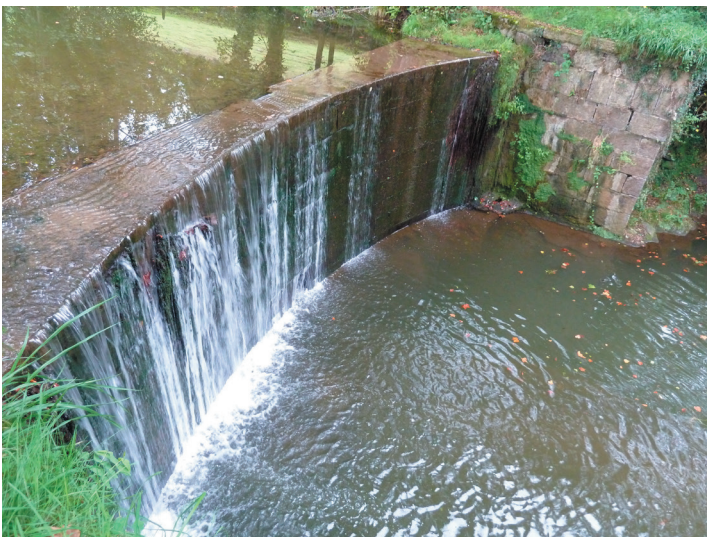
Fig. 23 Ansotegi. (Etxebarria. Bizkaia) Alto: 3,40 m. Largo 11,90m. Proyecto: Villareal de Berriz. Foto del autor.
