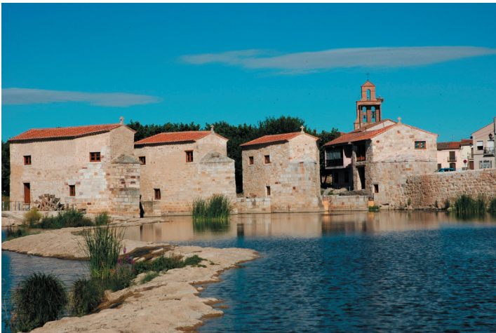
Fig. 8 Fotografía de las Aceñas de Olivares tras la finalización de la obra
