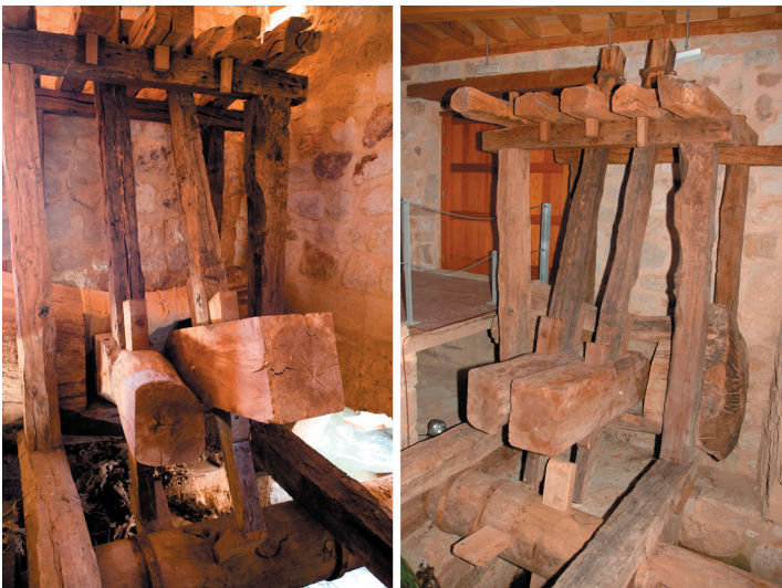
Fig. 9-11 El batán de las Aceñas de Olivares tras la finalización de la obra
