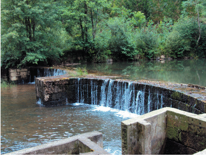
Fig.s 26/27 Errotabarri Arancibia. (Amoroto. Bizkaia) Tres arcos: 11,70; 11,10; 6,80 m. Alto: 1,90 m. Foto y dibujo del autor.
