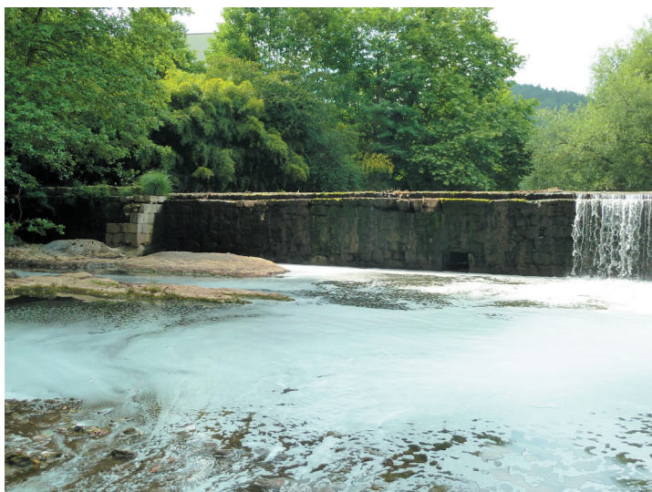
Fig. 11 Presa de Zubillaga.Oñati. (Gipuzkoa) Sillería,cuerpo de mampostería y cal y canto. Forro de tabla y recrecido moderno. ( Moraza, A. Buces, J. Arkeoikuska. 2009)
